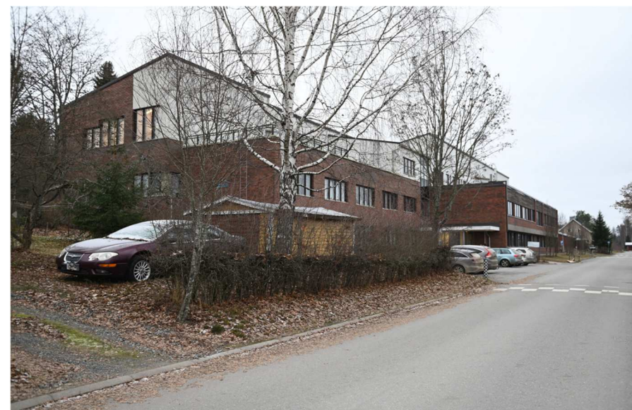
Kuva: Lähemäkitalo. Vanhan puolen katto on yhtenäistä pulpettikattoa, toisin kuin piirroksessa.
