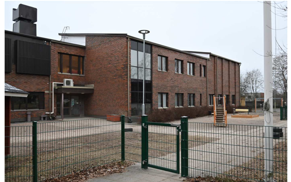
Kuva: Lähinnä talotekniikkaan liittyvät uudistukset ovat näkyvimpiä julkisivuissa tapahtuneita muutoksia sitten vuoden 1990 laajennuksen.
